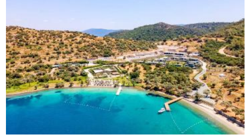
CENGİZ İNŞAAT BODRUM PROJESİ
