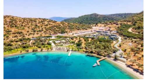
CENGİZ İNŞAAT BODRUM PROJESİ
